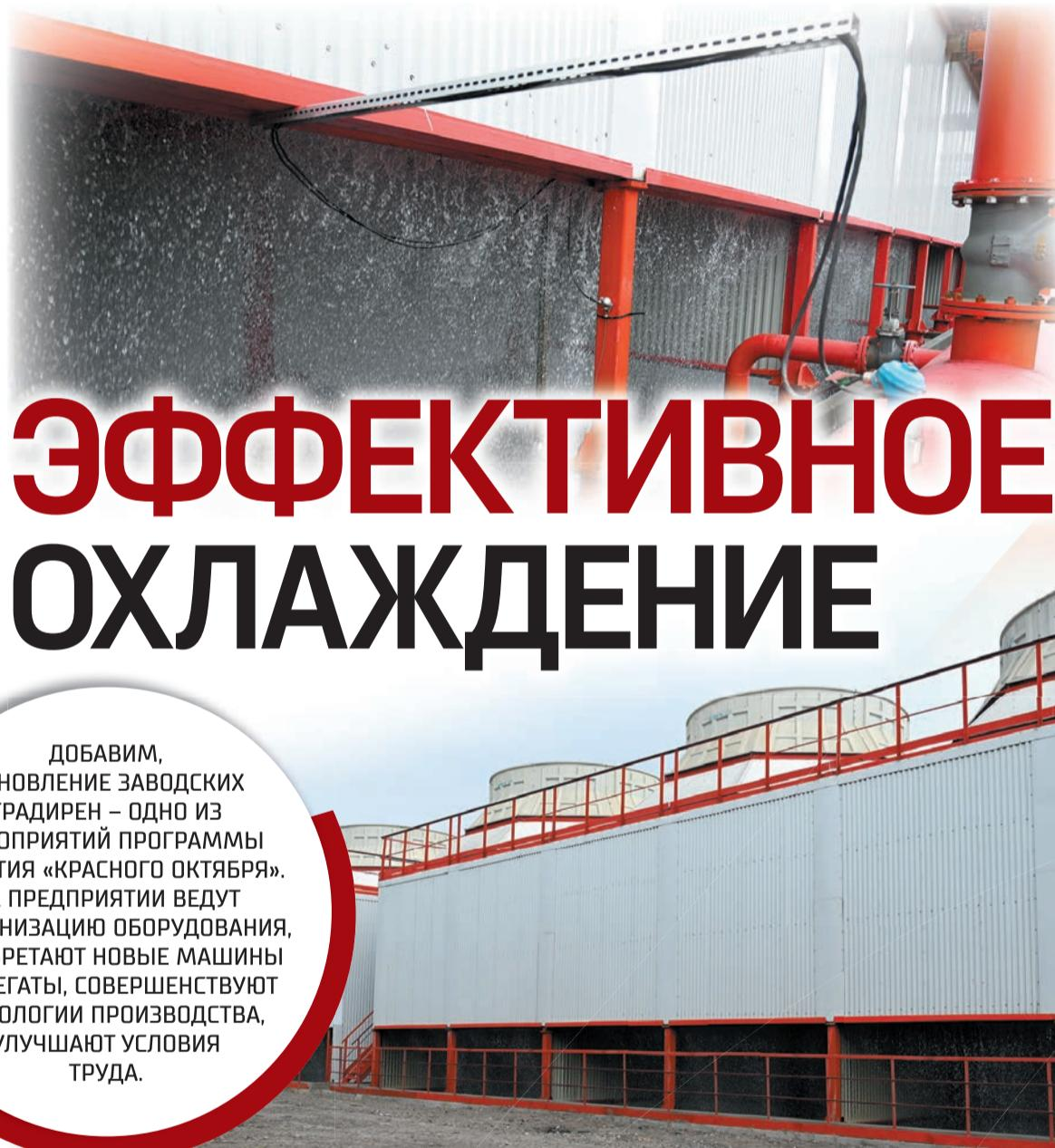
вода многократно используется, вращаясь в замкнутом обратном цикле. Благодаря новым градирням температура воды, поступающей на производство, понизилась с 36 до 26 градусов. Пуск новых градирен позволил снизить количество простоев оборудования на плановые ремонты и затраты предприятия на потребление электроэнергии.
