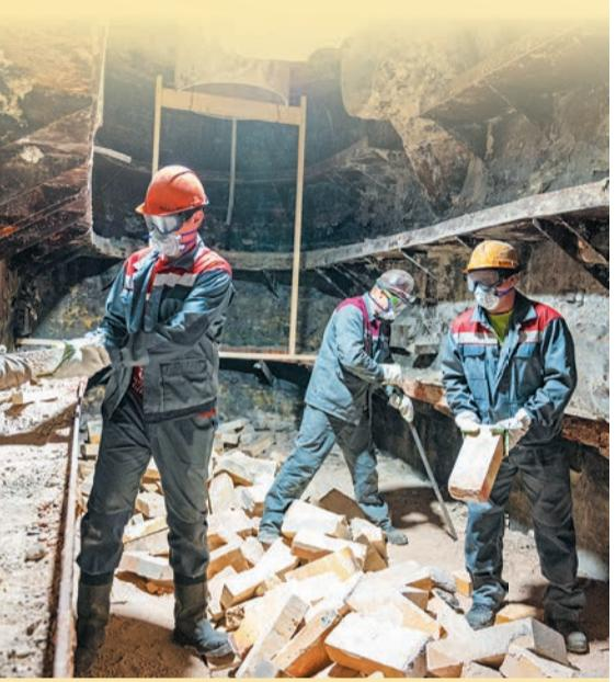
В цехе по производству извести, порошков и люнкерита [ЦПИПЛ] приступили к ремонту известково-обжигательной печи объемом 170 куб. м и мощностью 100 тонн обожженной извести в сутки.
